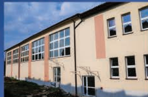
Budowa hali sportowej przy Publicznej Szkole Podstawowej nr 2 w Staszowie
